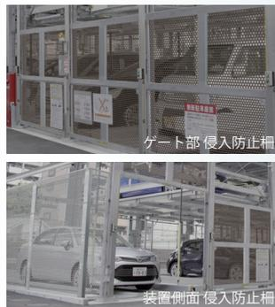
快適な操作を実現するとともに、安全性確保への対応として、装置の作動エリア内に誤って入ることを防止する「侵入防止柵」を設けました。
