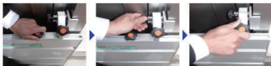
防水パネル固定金具を使って、立駐柱に固定します。
